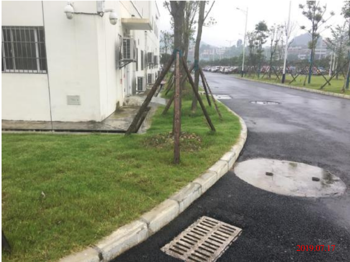
图 4 排水沟及雨水口实施情况
