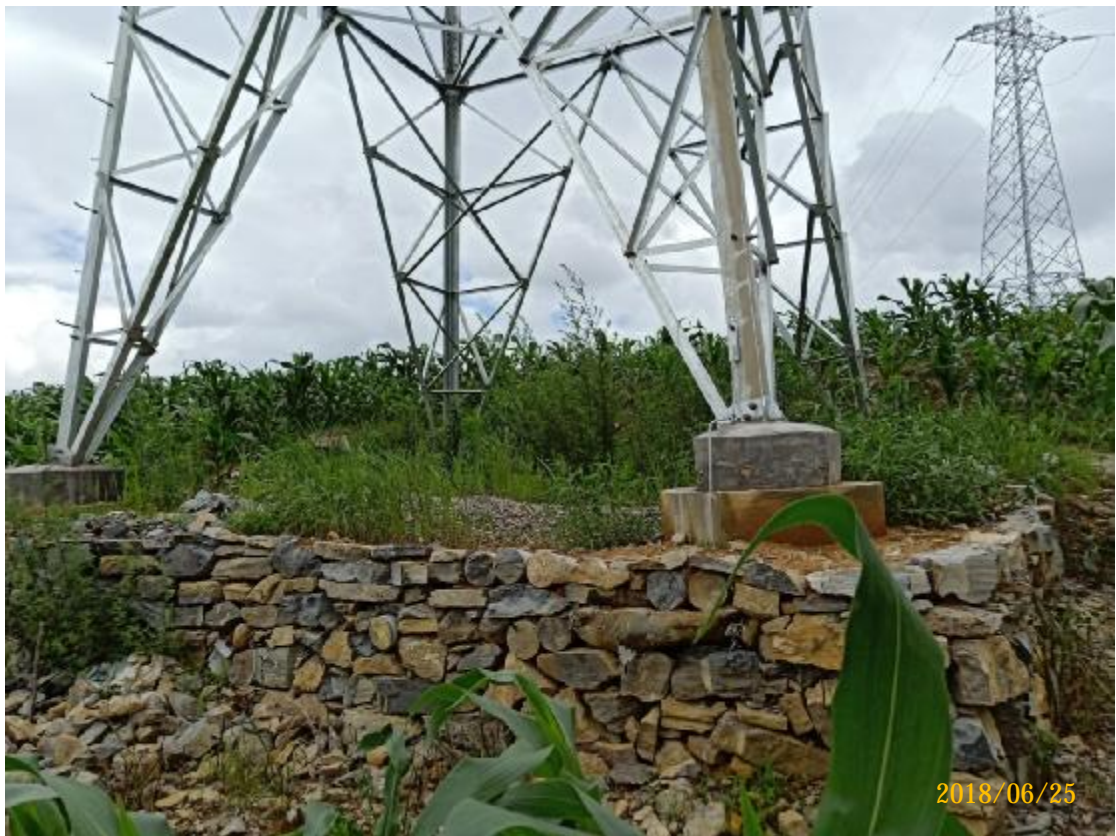
图 12 110kV 牌林线 003 号塔基干砌石挡墙实施情况
