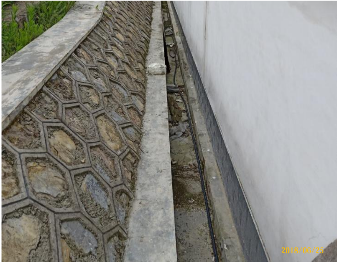
图 13 110kV 牌庄变电站围墙排水沟实施情况
