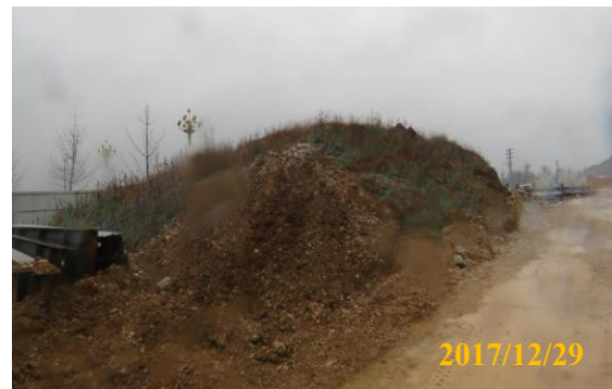
已实施的表土临时遮盖后植被恢复
