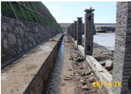
已实施的综合护坡和排洪沟现状
