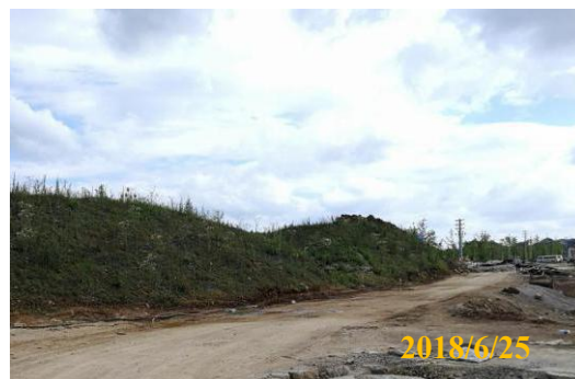
已实施的表土临时遮盖后植被恢复
