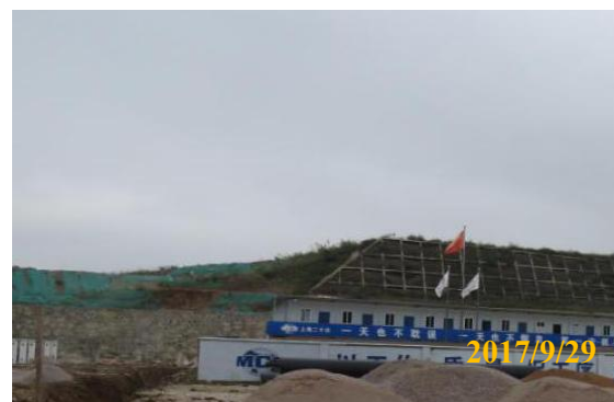
已实施的边坡临时遮盖和植草综合护坡
