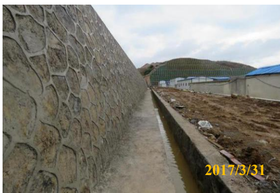
辅助区已实施的挡土墙和排水沟
