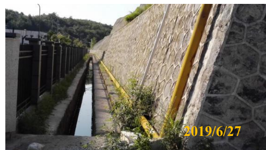
生产区已实施的护坡及排水沟
