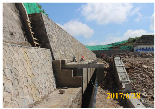
已实施的挡土墙和排洪沟现状
