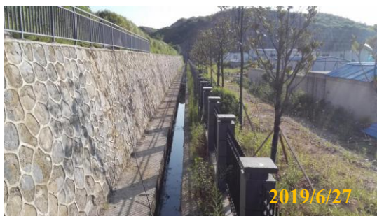
辅助区已实施的挡土墙及排水沟
