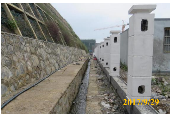
已实施的综合护坡和排洪沟现状
