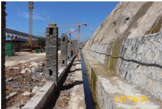
已实施的综合护坡和排洪沟现状
