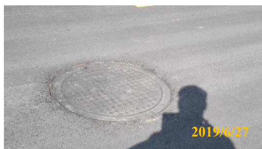
生厂区已实施的雨水检查井
