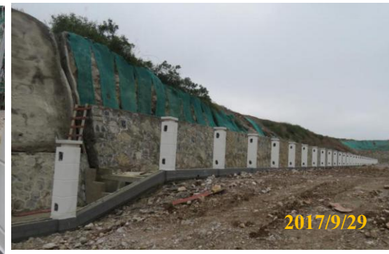
已实施的挡土墙和排洪沟现状
