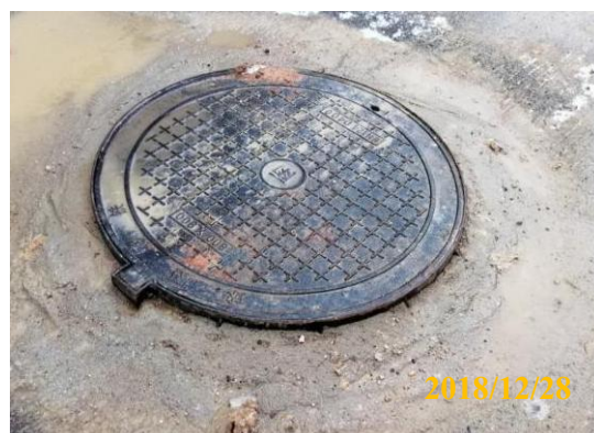
已实施的雨水检查井
