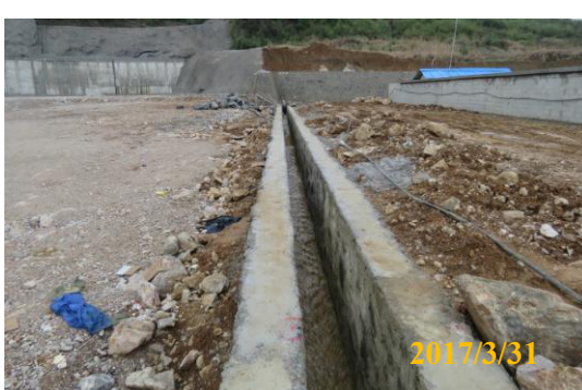
已实施的挡土墙和排水沟
