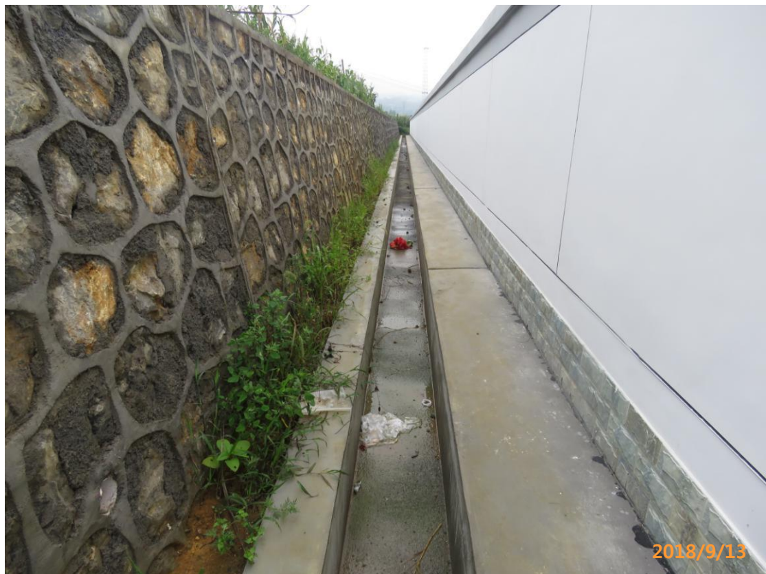
图2 大方 110kV 金龙变电站排水沟
