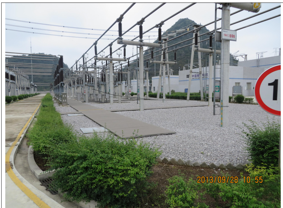
图3 变电站内部实施的排水沟及植物措施情况
